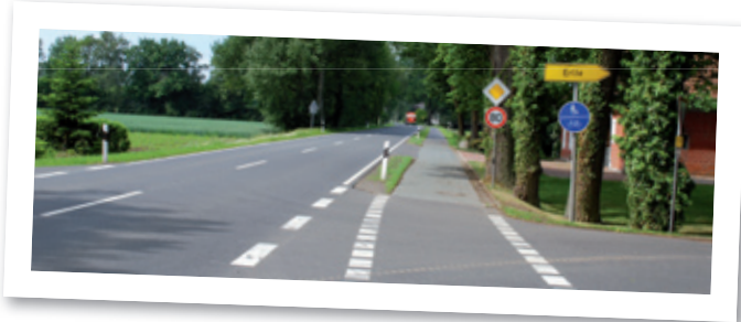
Ausbau der Schneiderkruger Straße
